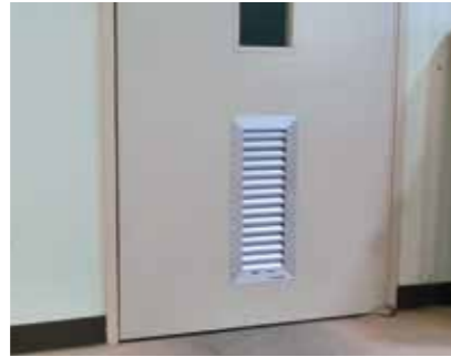
施工事例 室外側
